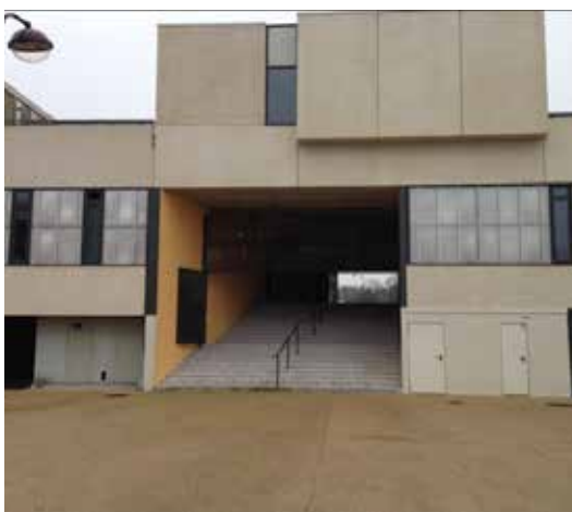
Des espaces neufs peu sécurisants.
