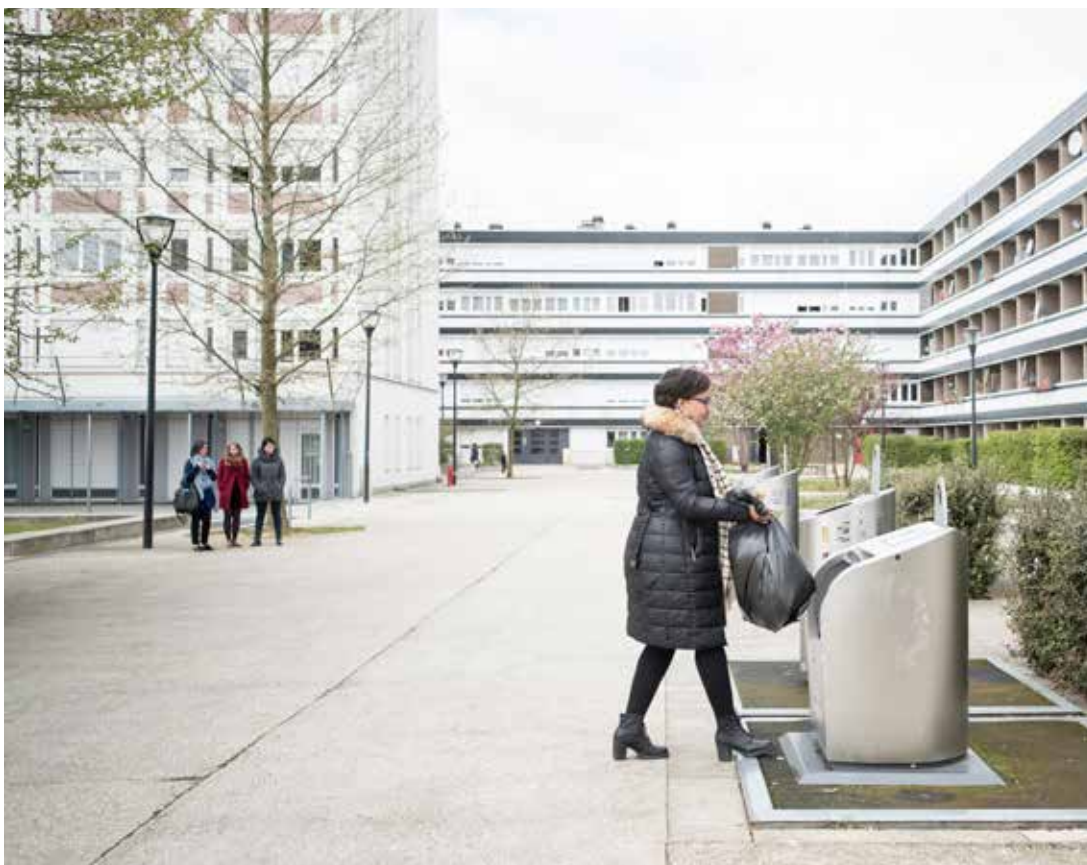
Des conteneurs enterrés pour faciliter la gestion des ordures ménagères.
